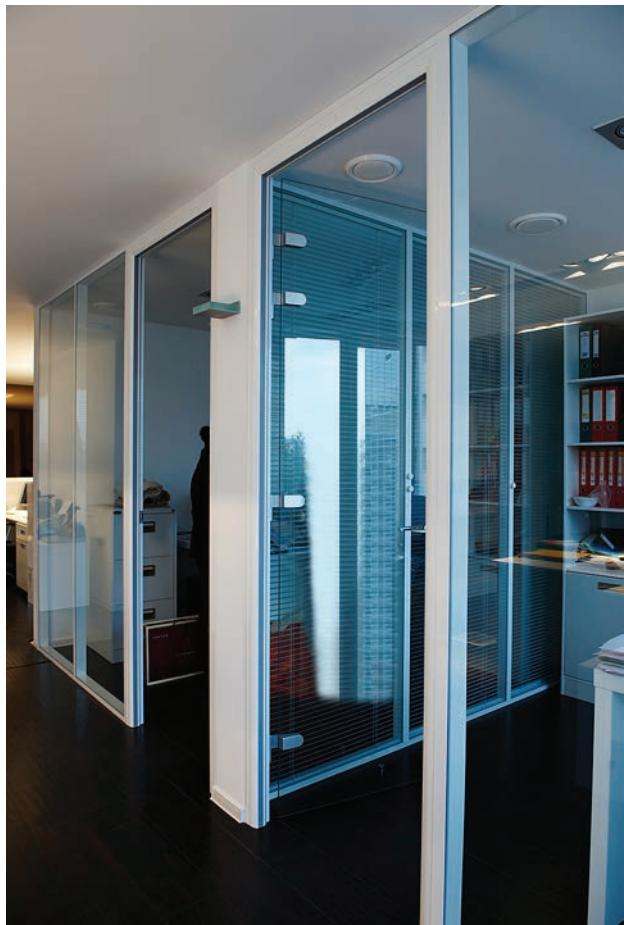
Возвведение стеклянных перегородок в офисных помещениях не требует больших временных и финансовых затрат. При изготовлении, как правило, используется каленое стекло, которое отличается повышенной прочностью и стойкостью перед серьезными нагрузками. Доступны различные виды стекла и технологии его обработки. Допускается применение матовых и тонирующих декоративных пленок.
