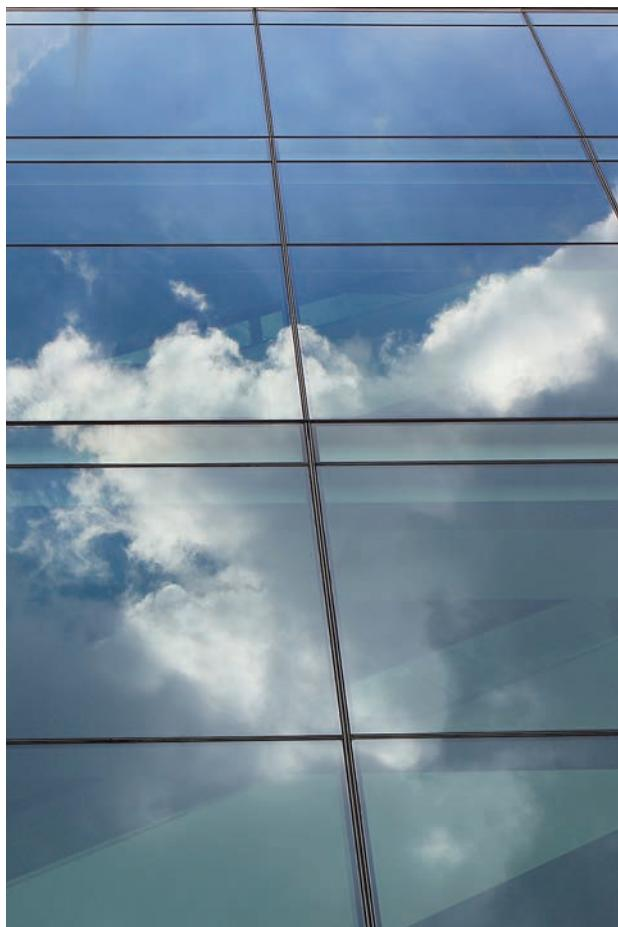
Стоечно-ригельное остекление – самый распространенный вариант витражного остекления фасадов. Представляет собой вертикальные и горизонтальные алюминиевые профили, пространство между которыми заполняется одинарным стеклом в холодном фасаде или многослойным стеклопакетом – в теплом.
