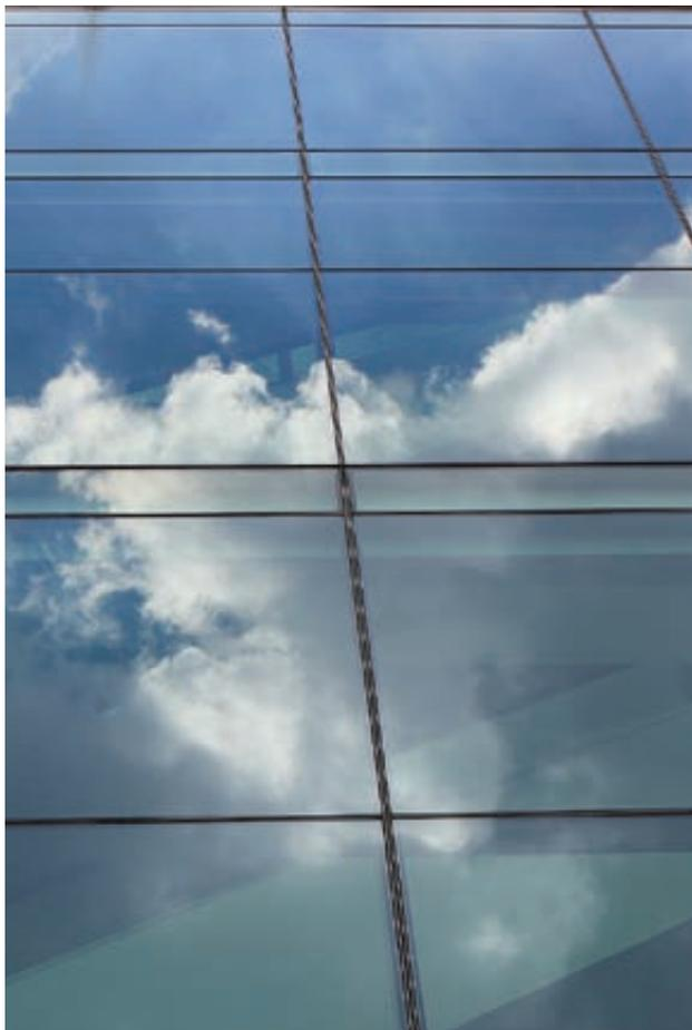
Стойечно-ригельное остекление – самый распространенный вариант витражного остекления фасадов. Представляет собой вертикальные и горизонтальные алюминиевые профили, пространство между которыми заполняется одинарным стеклом в холодном фасаде или многослойным стеклопакетом – в теплом.
