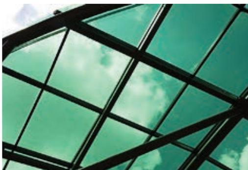
При этом тонированное стекло не требует специального ухода: поверхность с защитной пленкой очищается с помощью обычных моющих средств.
